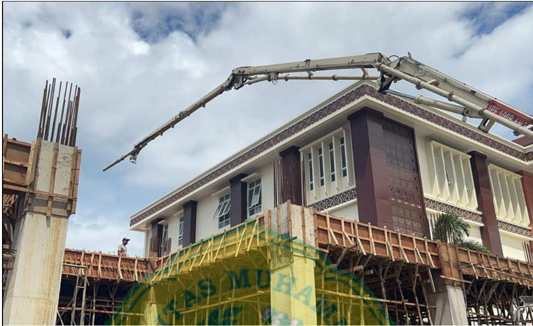
Gambar A.4.1 Proses Pengecoran Pelat Lantai Konvensional Sumber : Dokumentasi Lapangan (2024)
