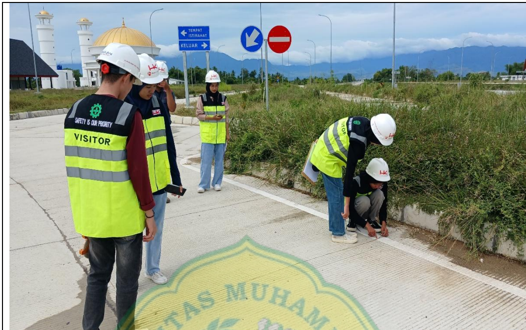
Gambar A.4.15 Pengukuran Bahu Jalan Ramp On/Off Rest Area Km 37b Waktu: Dokumentasi penulis (12 Juni 2025)
