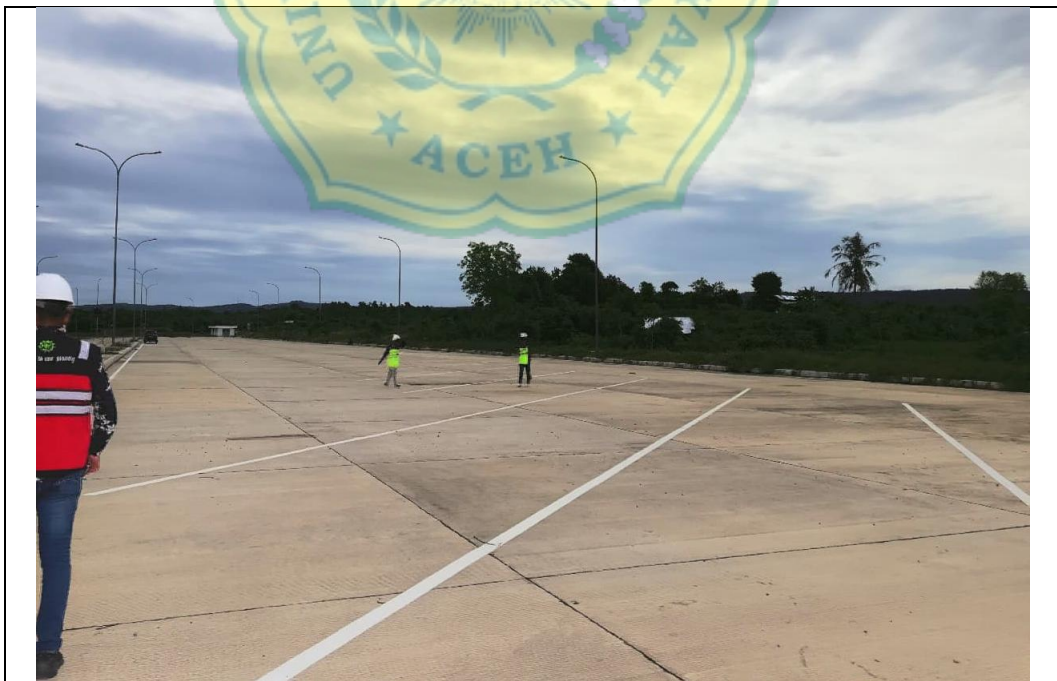
Gambar A.4.2 Area Parkir Kendaraan Golongan II/III/IV/V
