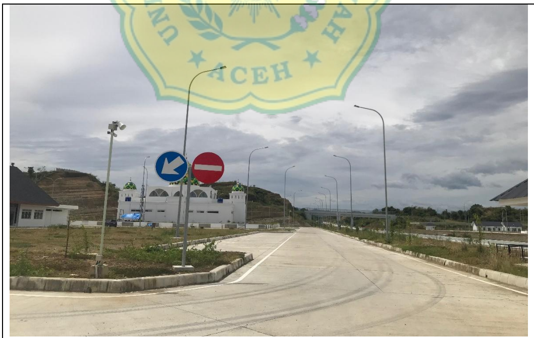
Gambar A.4.14 Jalur Ramp On/Off Rest Area Km 37b Waktu: Dokumentasi penulis (12 Juni 2025)
