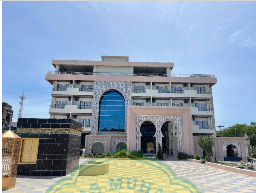
Gambar A.8 Gedung A1 Asrama Haji Banda Aceh
