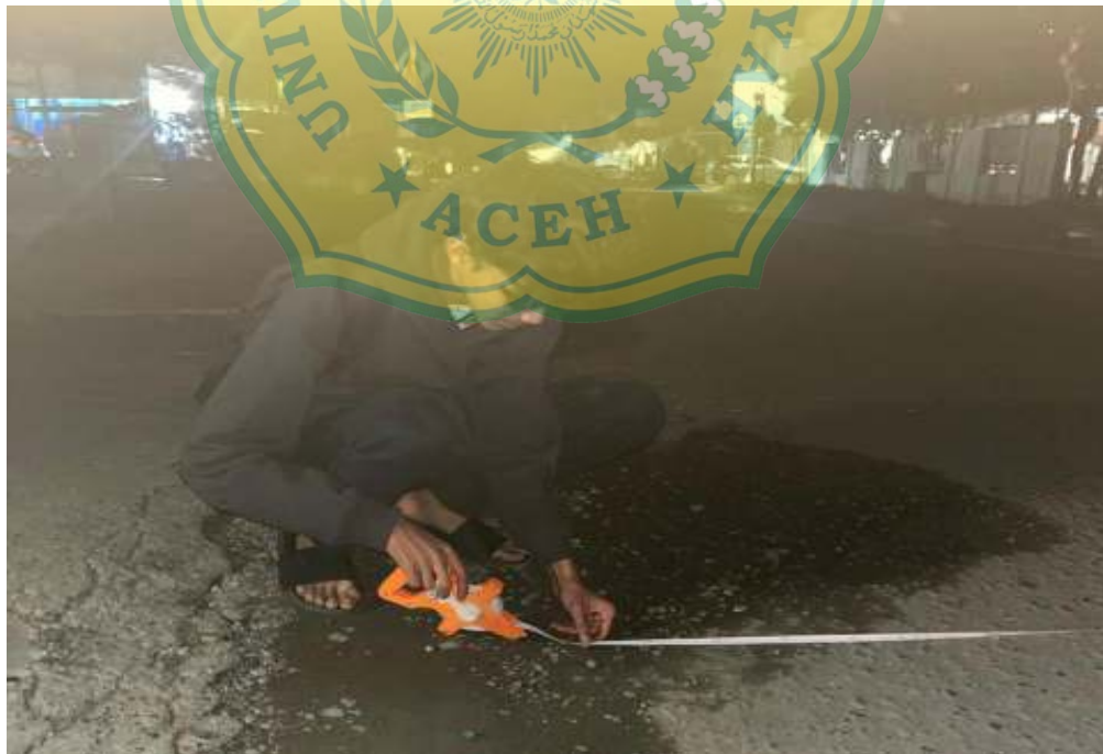
Gambar A.3.9 : Pengukuran Lebar Jalan Teuku Iskandar
