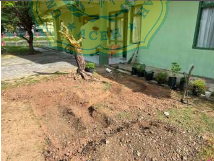
Gambar A.3.8 : Foto setelah penggalian Rain Garden
