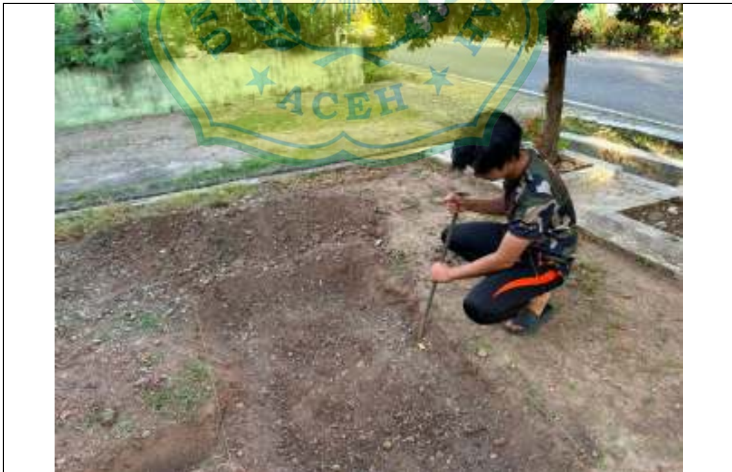
Gambar A.3.6 : Foto Proses pembuatan Cekungan Rain Garden
