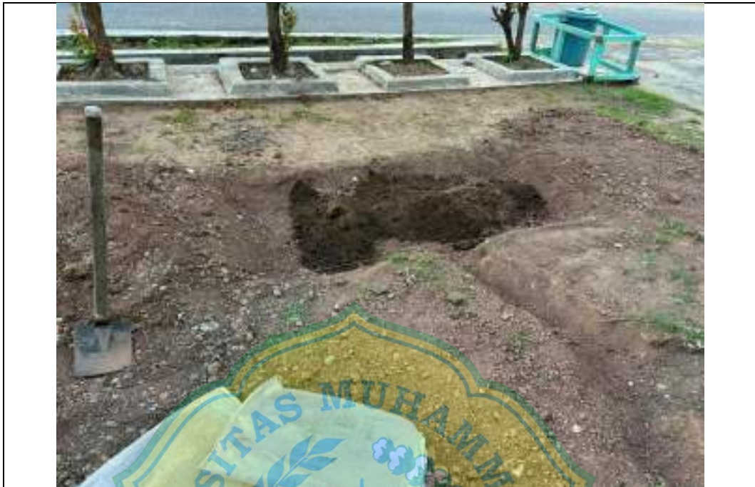
Gambar A.3.11 : Foto Proses pengisian tanah dan kompos ke Rain Garden
