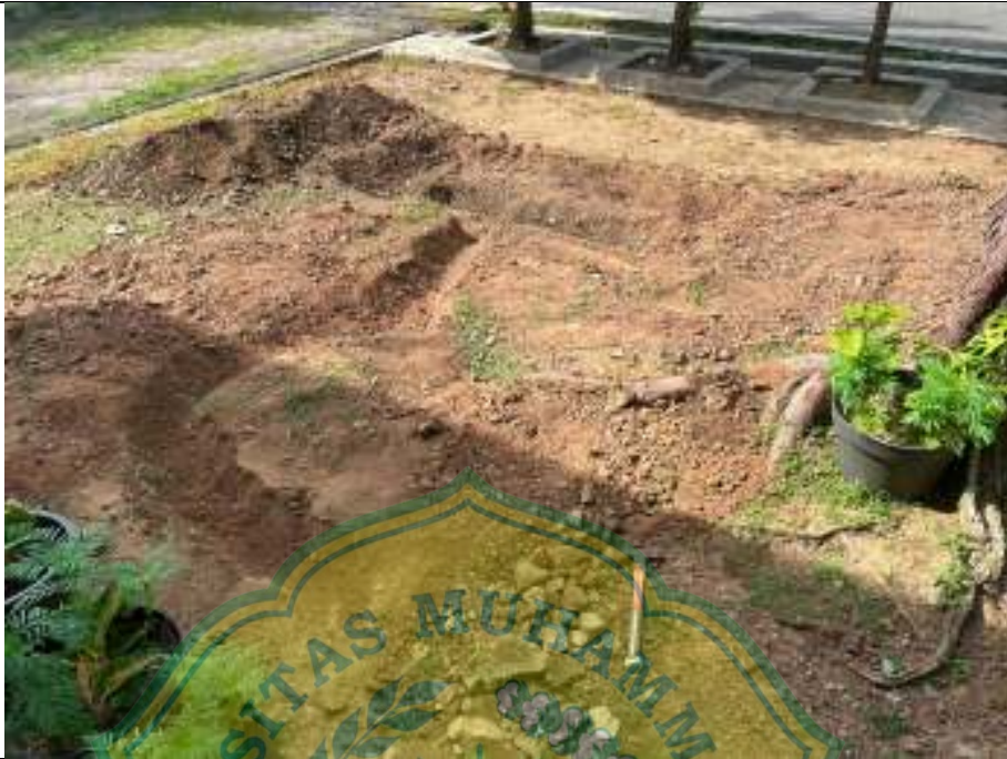
Gambar A.3.9 : Foto Pembuatan saluran inlet ke Rain Garden
