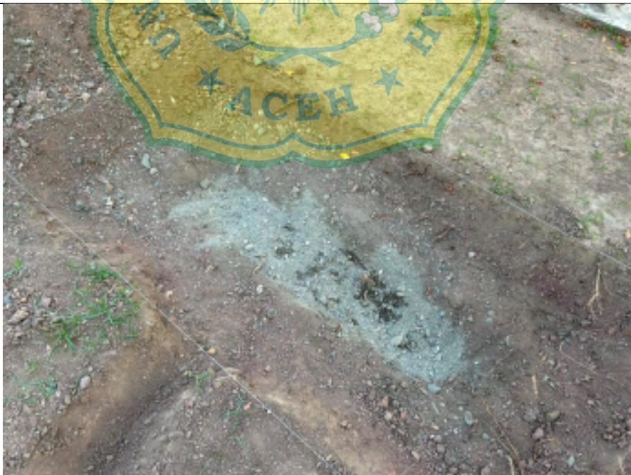
Gambar A.3.10 : Foto Proses pengisian pasir ke Rain Garden
