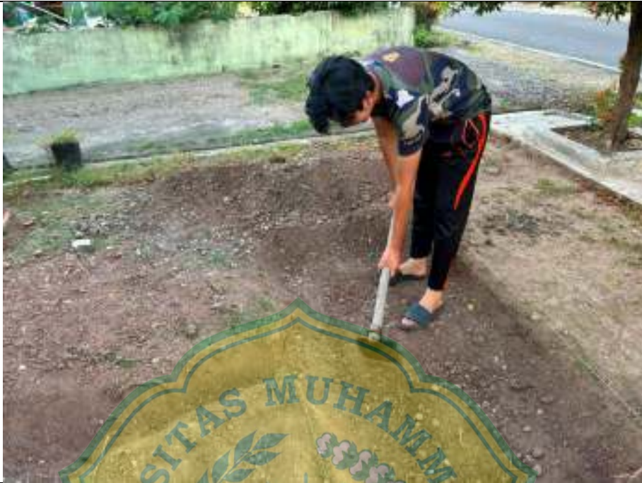
Gambar A.3.7 : Foto Proses Penggalian Rain Garden
