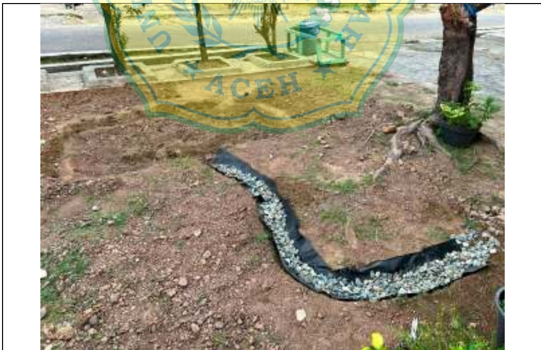
Gambar A.3.12 : Foto Proses pemasangan plastik dan kerikil di inlet
