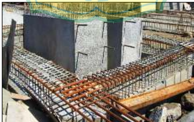
Gambar 5.14 Struktur Beton Bertulang Pracetak
