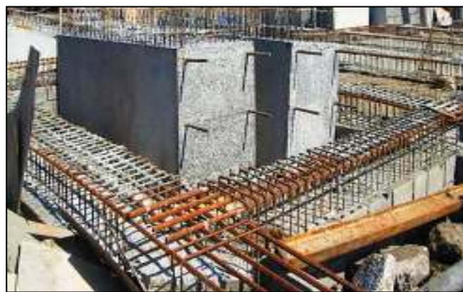
Gambar 4.13 Stuktur Beton Bertulang sumber : http://www.teknik-sipil.com , 2024
