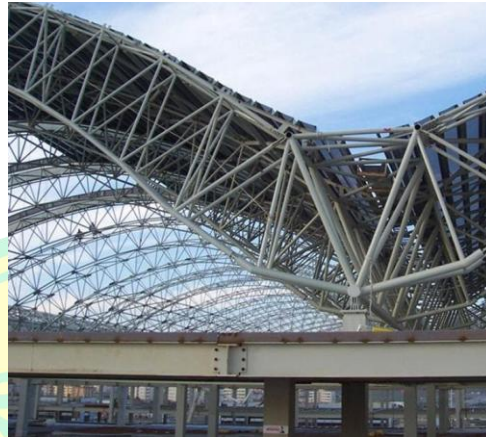
Gambar 5.8 Struktur space frame Sumber : Analisis pribadi, 2025
