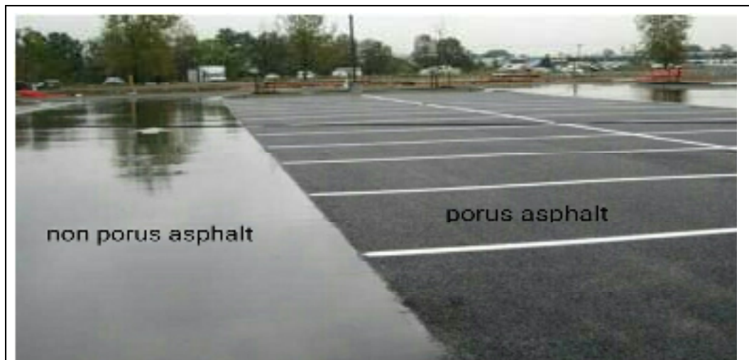
Gambar 2.1 Perbandingan Aspal Porus dengan aspal biasa
