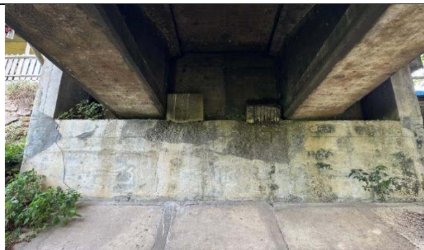
Gambar 4.6 Kondisi Komponen Dinding Belakang
