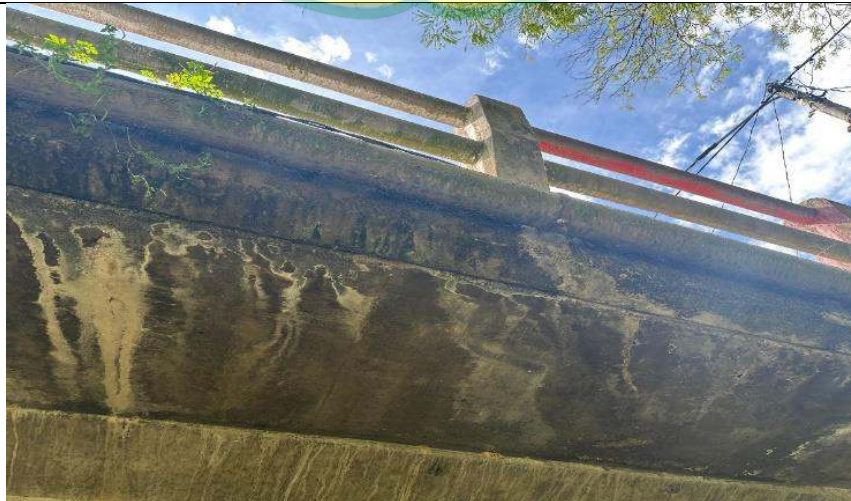
Gambar 4.4 Kondisi Komponen Dek Jembatan
