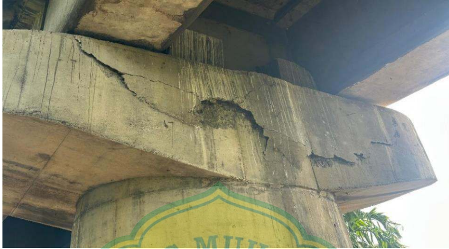
Gambar 4.3 Kondisi Komponen Pilar
