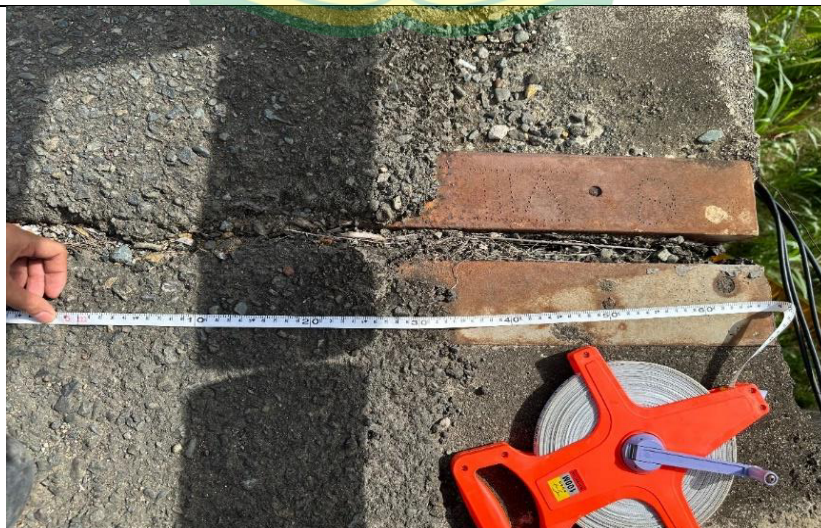
Gambar 4.9 Kondisi Komponen Join Jembatan
