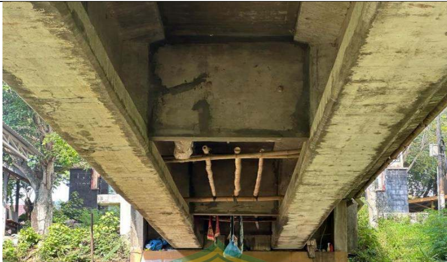
Gambar 4.1 Kondisi Komponen Gelagar
