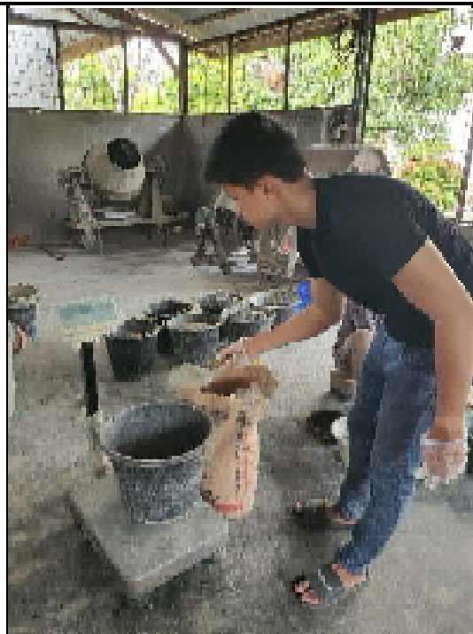
Timbang Material Untuk Pengecoran
