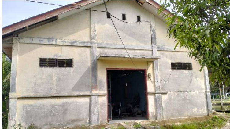
Gambar 2. 29 Tampak Heacery Indor (Sumber : Dokumentasi Pribadi, 2024)
