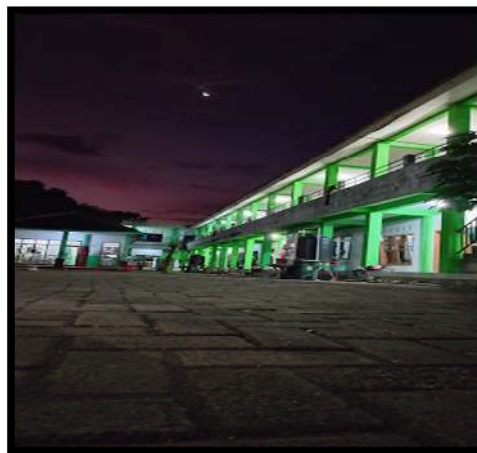
Gambar 2.8 Kondisi Bangunan Salafiyah Salafi'iyah asyhariah Sumber : dokumentasi pribadi, 2024
