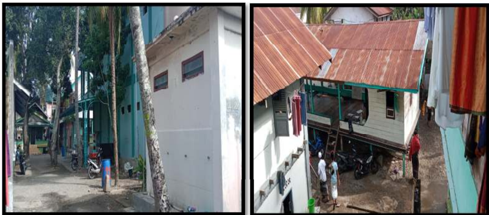
Gambar 2.4 Bangunan pengajian Dayah Ulee Titi Sumber dokumentasi pribadi, 2024
