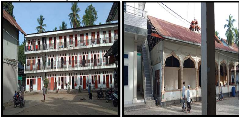
Gambar 2.3 kondisi Bangunan Dayah Ulee Titi Sumber: dokumentasi pribadi, 2024
