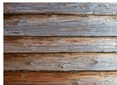
b. Dinding Kayu Dengan Celah-celah Kecil
