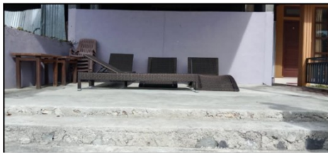
Gambar 2.12 Eksterior Area bejemur outdoor Anoi Itam Resort Sabang, Aceh (Sumber : Survey Lapangan, 2023)
