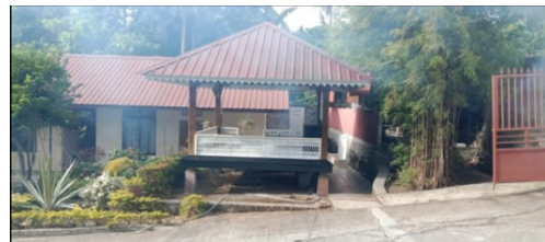
Gambar 2.9 Eksterior musholla Anoi Itam Resort Sabang, Aceh (Sumber : Survey Lapangan, 2023)
