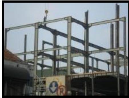
Gambar 5.11 : Struktur Rangka Baja (Sumber : www.Konstruksibesibaja.com )
