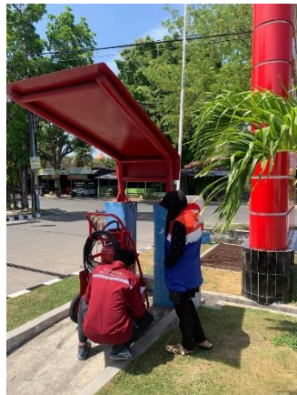
Melakukan pengecekan APAB
