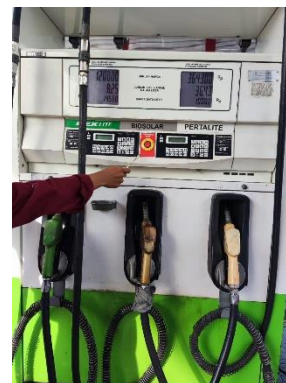
Tombol instalasi otomatis yang ada pada dispenser pengisian bahan bakar
