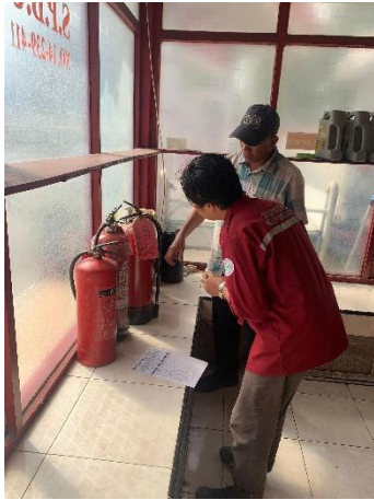
Melakukan pengecekan APAR 9 kg
