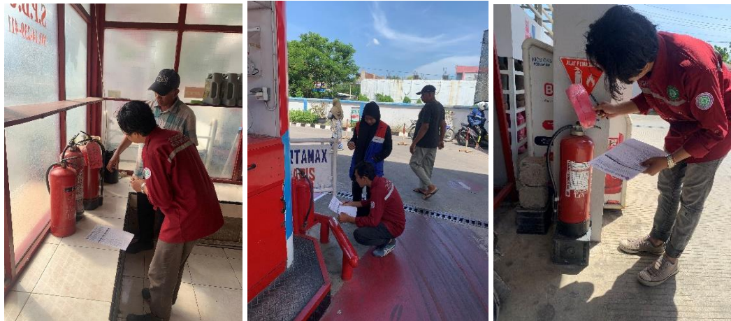
Gambar 6. 1 Pengecekan Alat Pemadam Api Ringan (APAR) 9 kg
