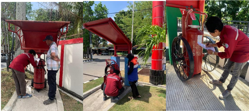
Gambar 6. 2 Pengecekan Alat Pemadam Api Berat 80 kg
