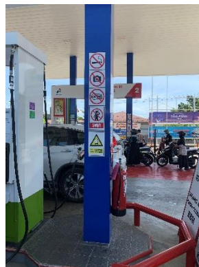
Pengecekan rambu rambu yang ada pada dispenser
