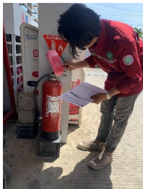
Pengecekan Kualitas dan Kuantitas APAR
