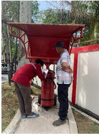
Melakukan pengecekan APAB 80 kg
