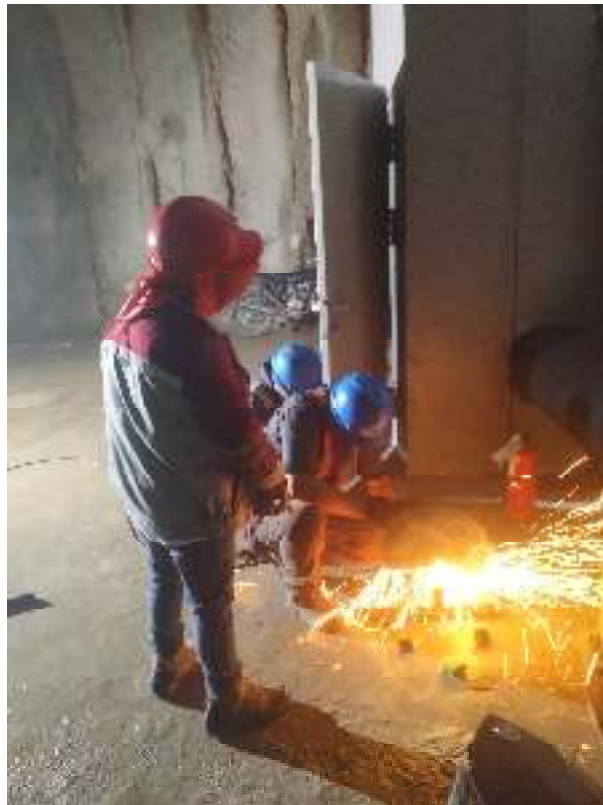
Gambar 6.4 Pemotongan Pipa
