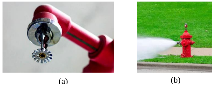
Gambar 5.15 (a) Springkler dan (b) Fire Hydrant Sumber: https://damkar.banacehkota.go.id , 2023
