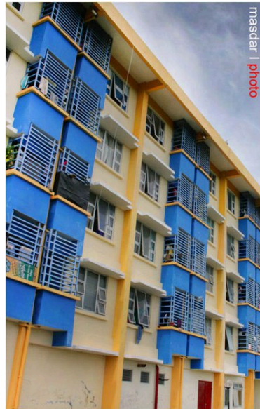
Gambar 2.1 : Bangunan Rusunawa Banda Aceh Sumber : (tribunnews.com)
