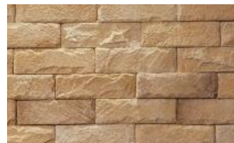
Gambar 5.11 penutup dinding luar batu alam dan andesit (Sumber : http://www.renovasirumah.com , 2020)
