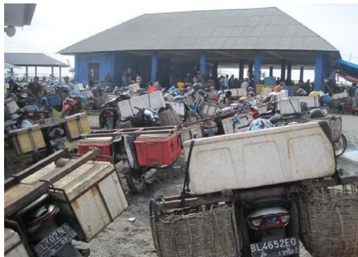
Gambar : PPI Meulaboh Aceh Barat Sumber : Foto Survei, 2020
