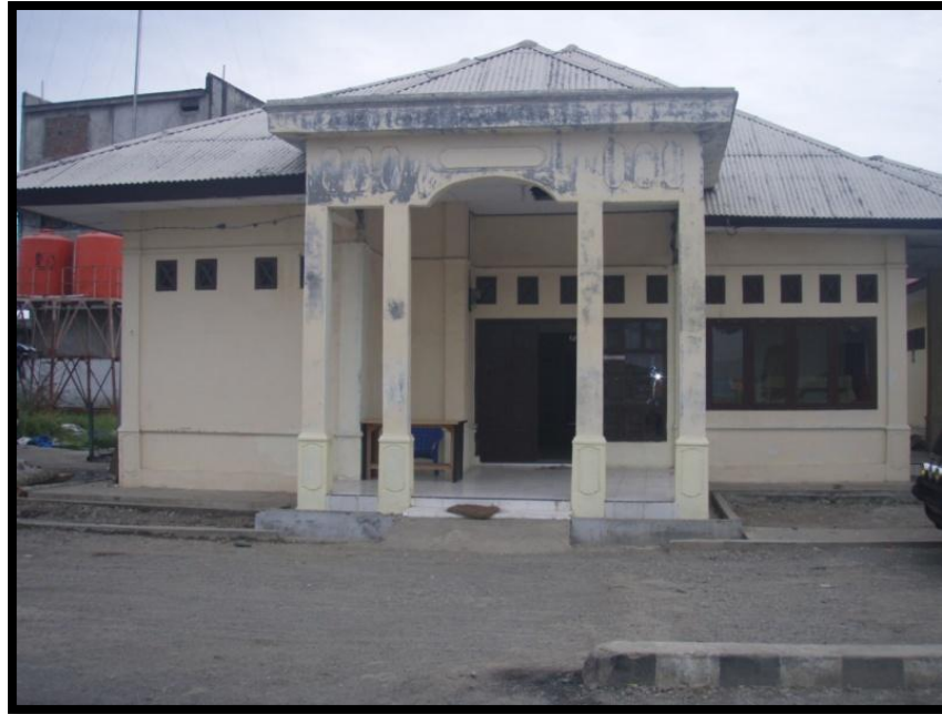
Gambar : PPI Meulaboh Aceh Barat Sumber : Foto Survei, 2020
