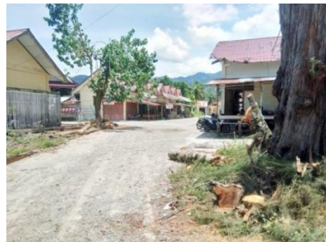
Gambar 2.4 Area jalan yg belum diaspal Sumber : Data Survey , 2020
