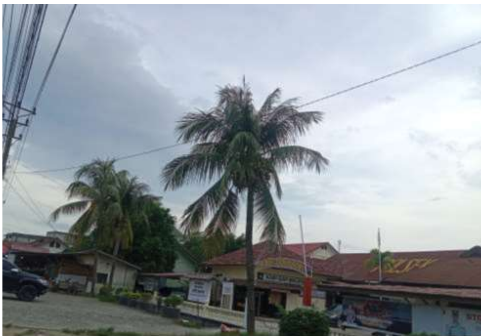
Gambar A.3.13 Kondisi kantor yang lebih rendah dari pada jalan Sumber : Dokumentasi Lapangan, 20/12/2023
