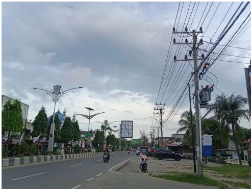
Gambar A.3.14 Kondisi jalan di perkotaan Sumber : Dokumentasi Lapangan, 20/12/2023
