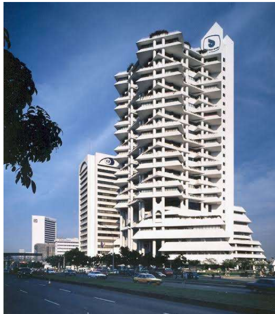
Gambar 3.1 Gedung Wisma Dharmala Sakti
