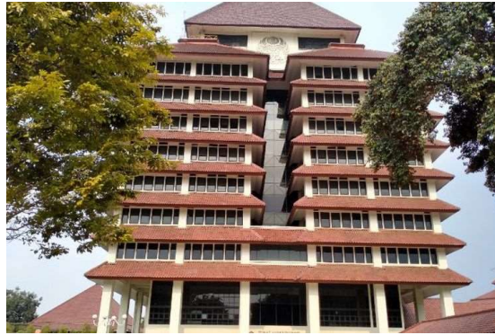
Gambar 3.6 Tampak Gedung Rektorat Universitas Indonesia Sumber : https://sekar.ui.ac.id , 2023
