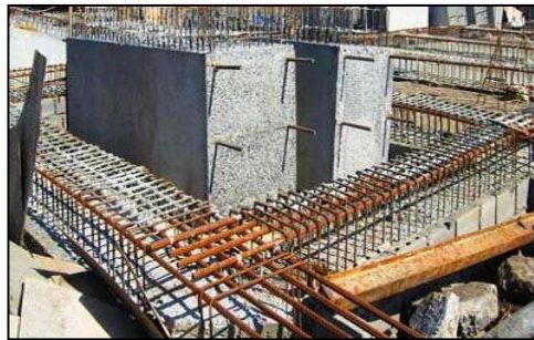
Gambar 5.8 Stuktur Beton Bertulang Sumber: http://www.teknik-sipil.com
