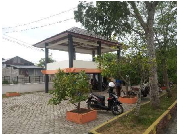
Gambar 2.5 Penyalahgunaan Area Parkir
