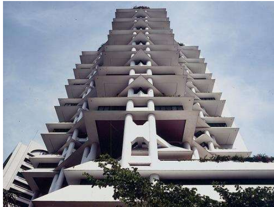
Gambar 3.2 Teritisan Atap Gedung Wisma Dharmala Sakti Sumber : wikiarquitectura.com, 2023
