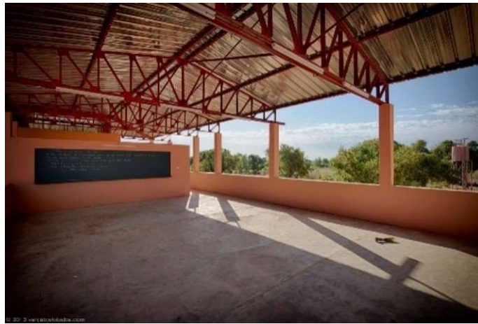
Gambar 2.13 Kuda-kuda pada atap bangunan panti asuhan Sumber: https://www.archdaily.com
