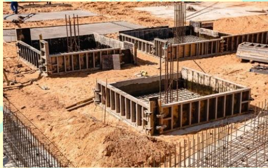
Gambar 5. 5 Pondasi Tapak dan Tiang Pancang (Sumber: https://demix.co.id/ , 2025)
