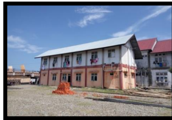
Gambar 2.10 Gedung Dapur Umum Sumber : Dokumen Pribadi 2020
