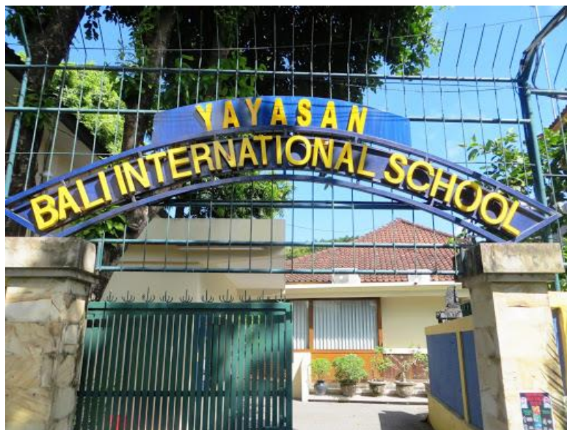
Gambar 2.22 Pintu Gerbang Masuk Sekolah Sumber: https://www.google.com , 2020
