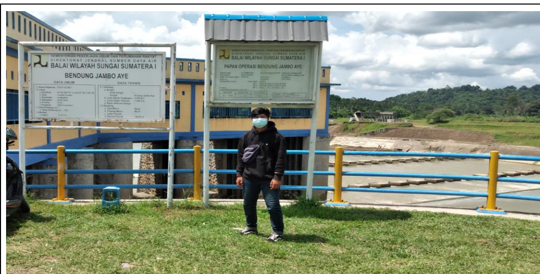
Gambar A.9. Pos Bendung Irigasi Jambo Aye . Sumber : Dokumen Pribadi.
