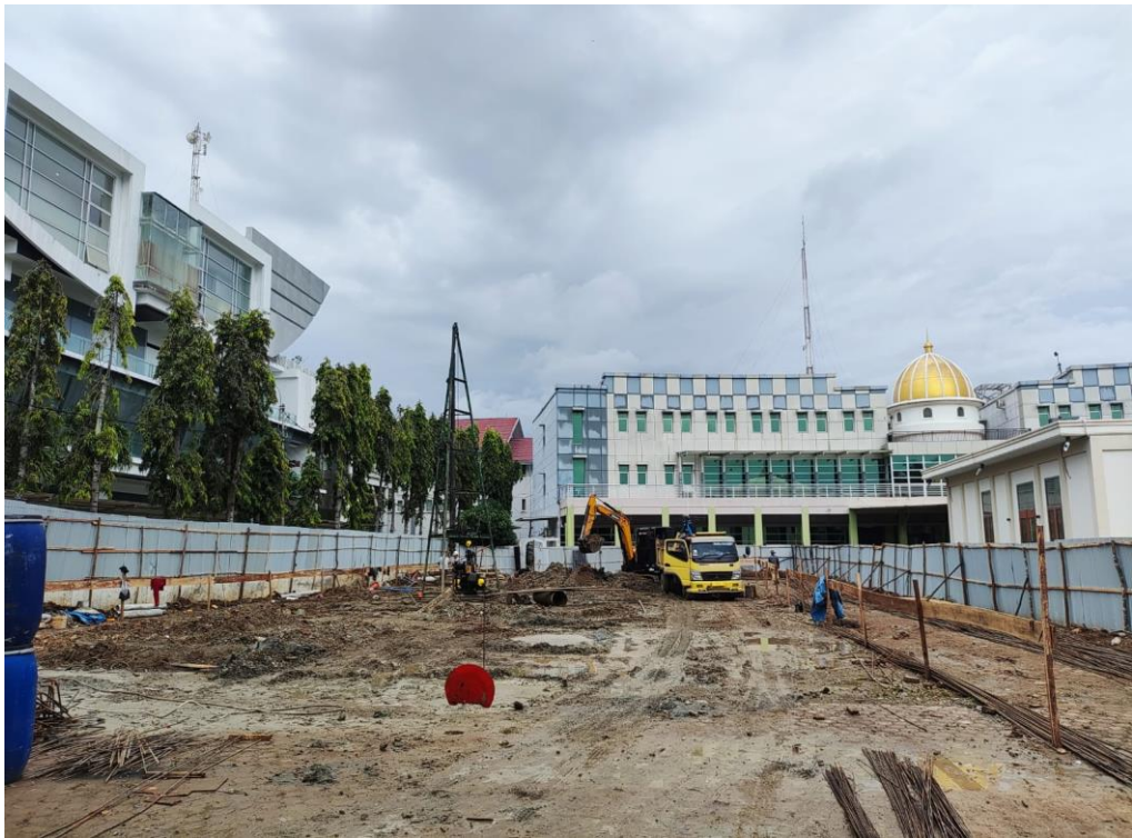
Gambar A.1.4 : Keadaan Kondisi Penelitian Pembangunan Gedung PLIDHUT Sumber : Selasa, 22 Desember 2023
