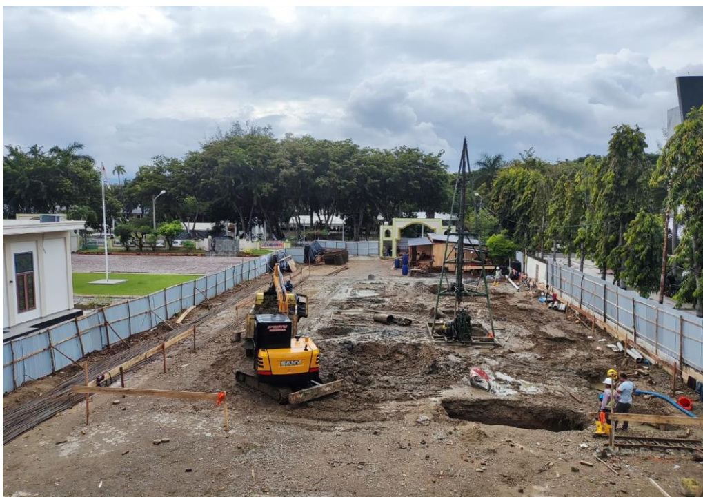
Gambar A.1.5 : Keadaan Kondisi Penelitian Pembangunan Gedung PLIDHUT Sumber : Selasa, 22 Desember 2023
