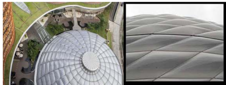
Gambar 4.18 Material Atap ETFE (Sumber : http://www.tridome.co.id/id/proyek/etfe )
