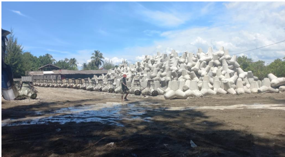
Gambar 4.4 : Gambar tumpukan bangunan pemecah gelombang
