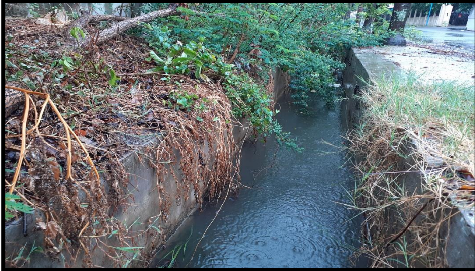
Gambar A.1.9 Saluran Existing SB Sumber : Survey Lapangan
