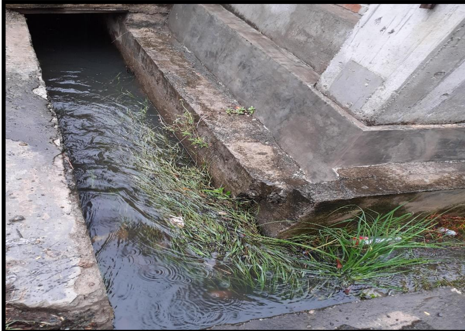
Gambar A.1.13 Saluran Existing SB Sumber : Survey Lapangan
