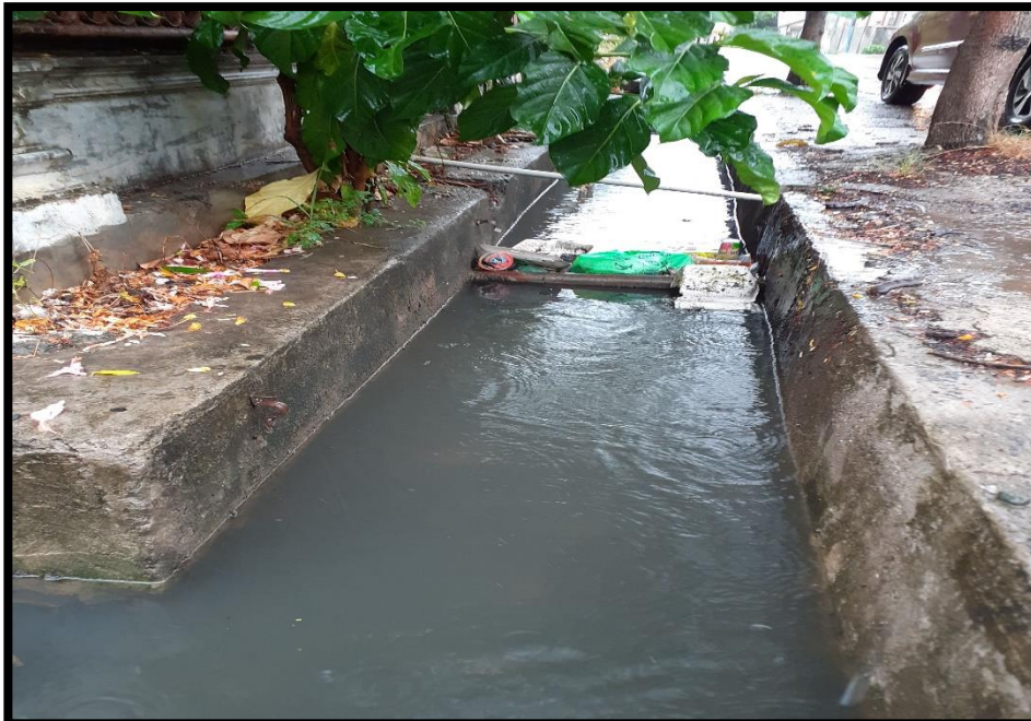
Gambar A.1.14 Saluran Existing SB Sumber : Survey Lapangan
