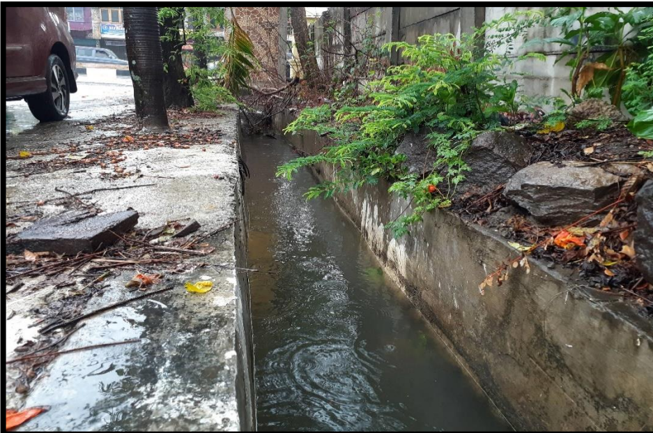
Gambar A.1.10 Saluran Existing SB Sumber : Survey Lapangan
