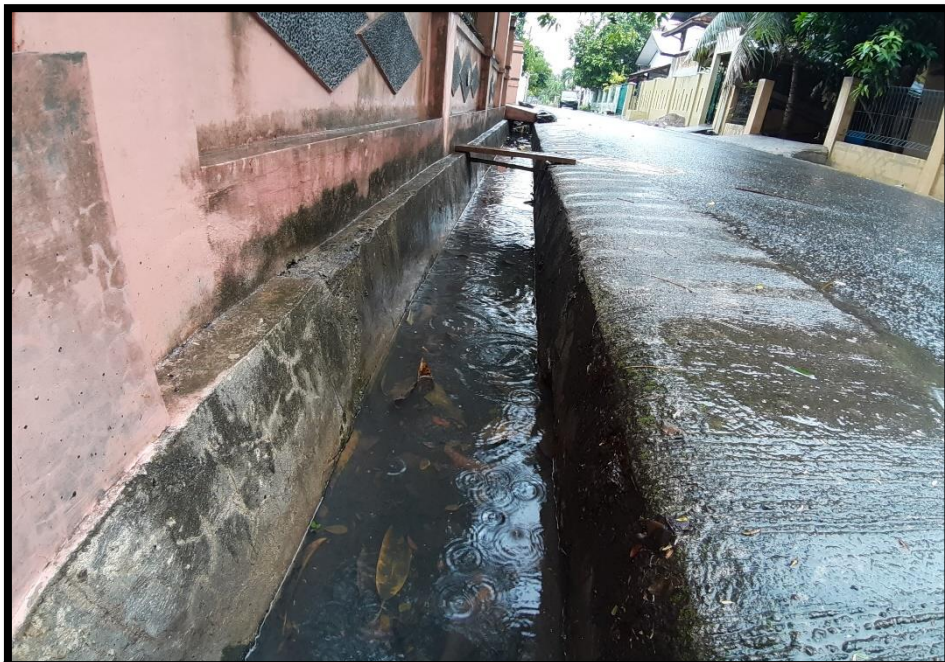
Gambar A.1.12 Saluran Existing SB Sumber : Survey Lapangan
