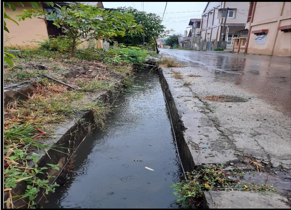
Gambar C.1.15 Saluran Existing SB Sumber : Survey Lapangan
