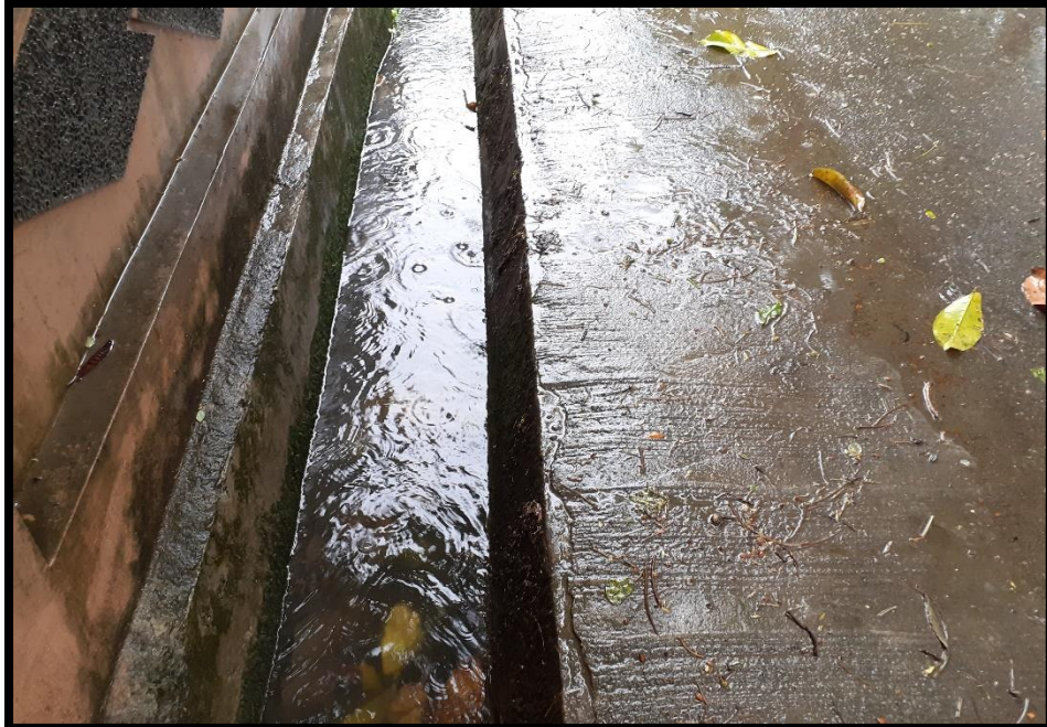
Gambar A.1.11 Saluran Existing SB Sumber : Survey Lapangan
