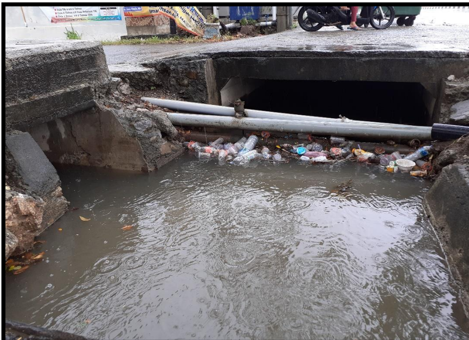
Gambar C.1.16 Saluran Existing SB Sumber : Survey Lapangan
