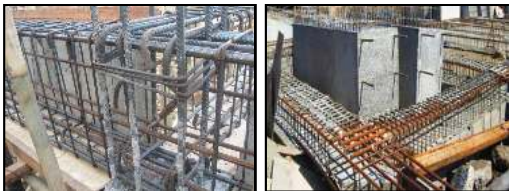
Gambar 4.23 Stuktur Beton Bertulang Sumber : Analisis Data, 2021
