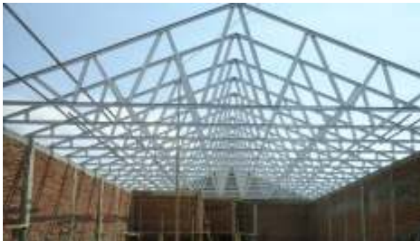
Gambar 5.13 Stuktur Atap Baja ringan Sumber : Analisis Data, 2021
