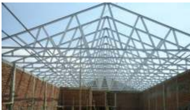
Gambar 4.24 Stuktur Atap Baja ringan Sumber : Analisis Data, 2021
