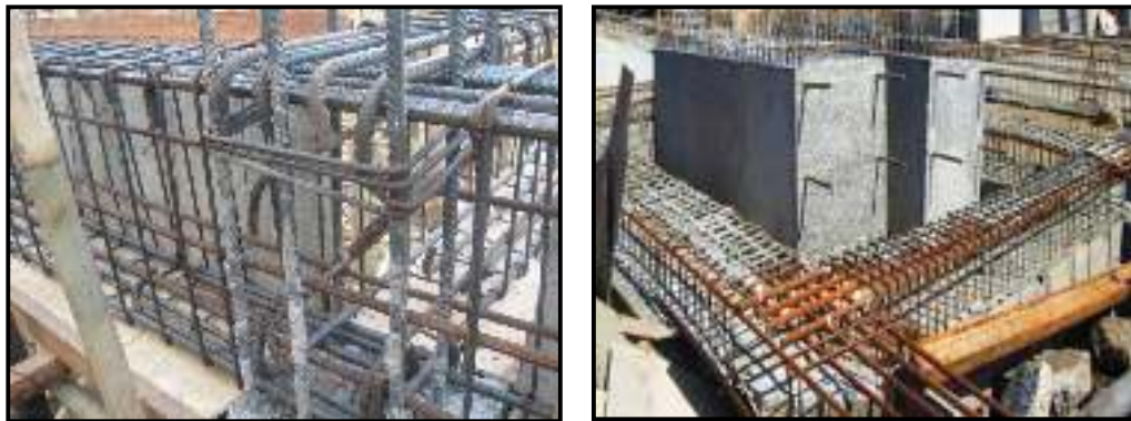
Gambar 5.11 Stuktur Beton Bertulang Sumber : Analisis Data, 2021
