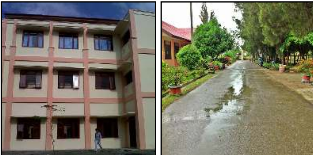
Gambar 2.3 Tampak Ruang Kelas dan Jalan Akses Sumber : Analisis Data, 2019
