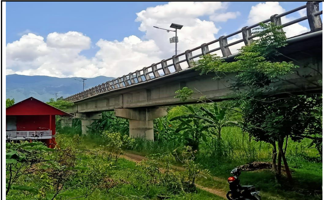
Gambar A.6 : Jembatan Lubok Sukun Sumber : Lokasi Penelitian (2021)
