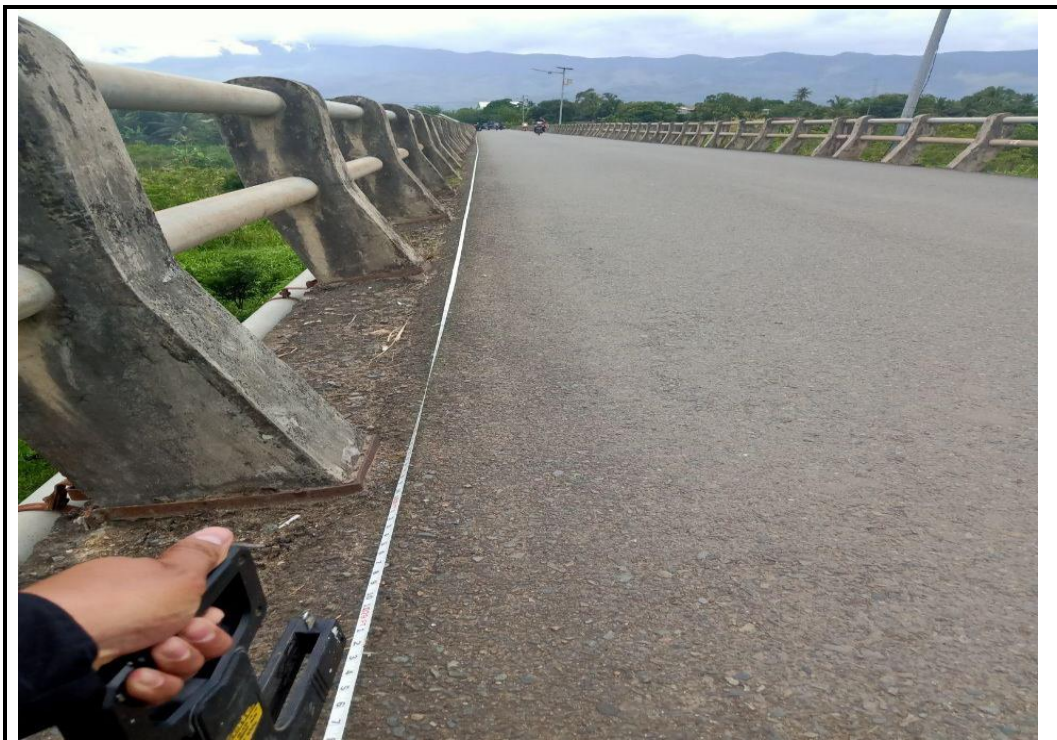
Gambar A.8 : Pengukuran langsung panjang jembatan
