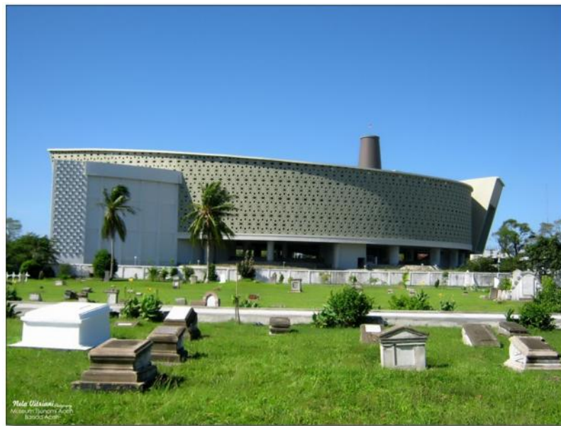
Gambar 2.1 Museum Tsunami Aceh Sumber: Dokumentasi Pribadi, 2020
