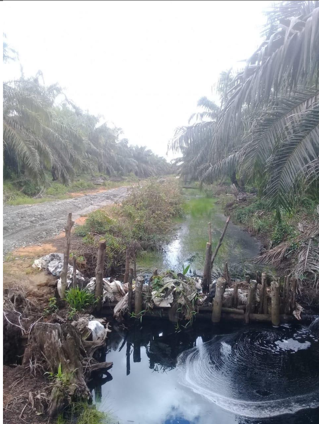
Gambar A.3 : Foto saluran PT TAS Sumber : Dokumen Pribadi 2022
