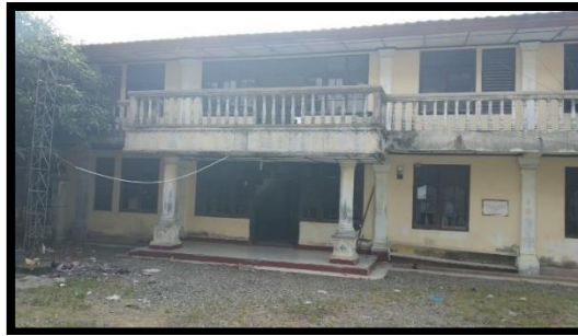
Gambar 2.14 Tampak Depan Panti Sumber : Dokumentasi pribadi, 2020
