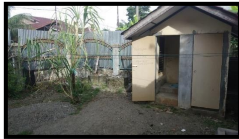
Gambar 2.9 Toilet Sumber : Dokumentasi pribadi, 2020
