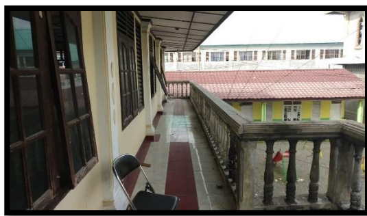
Gambar 2.20 Balkon Sumber : Dokumentasi pribadi, 2020
