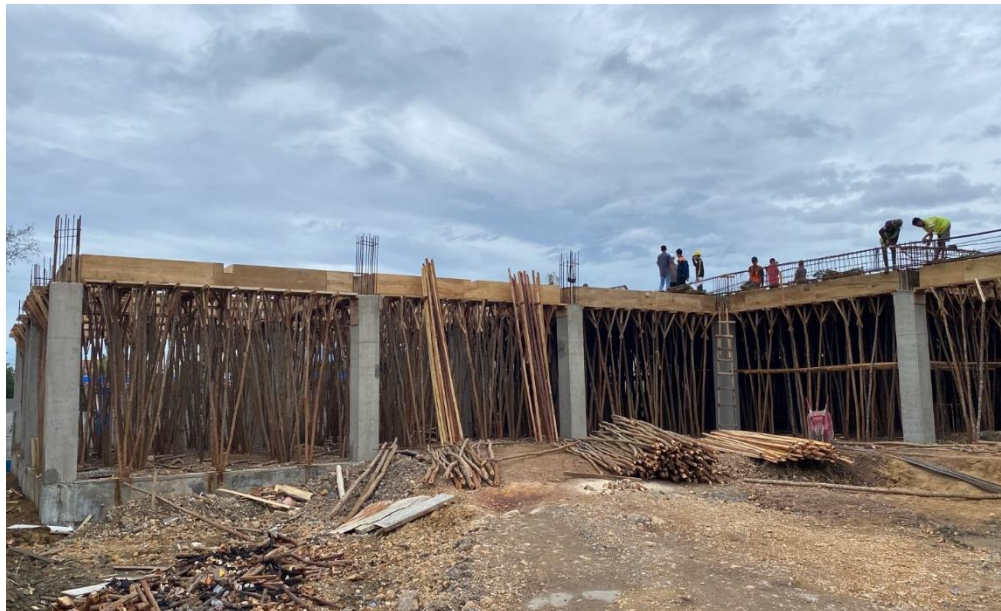
Lampiran A.2.2 : Pemasangan Bekisting Balok dan Plat Lantai 1 waktu : 29 November 2023
