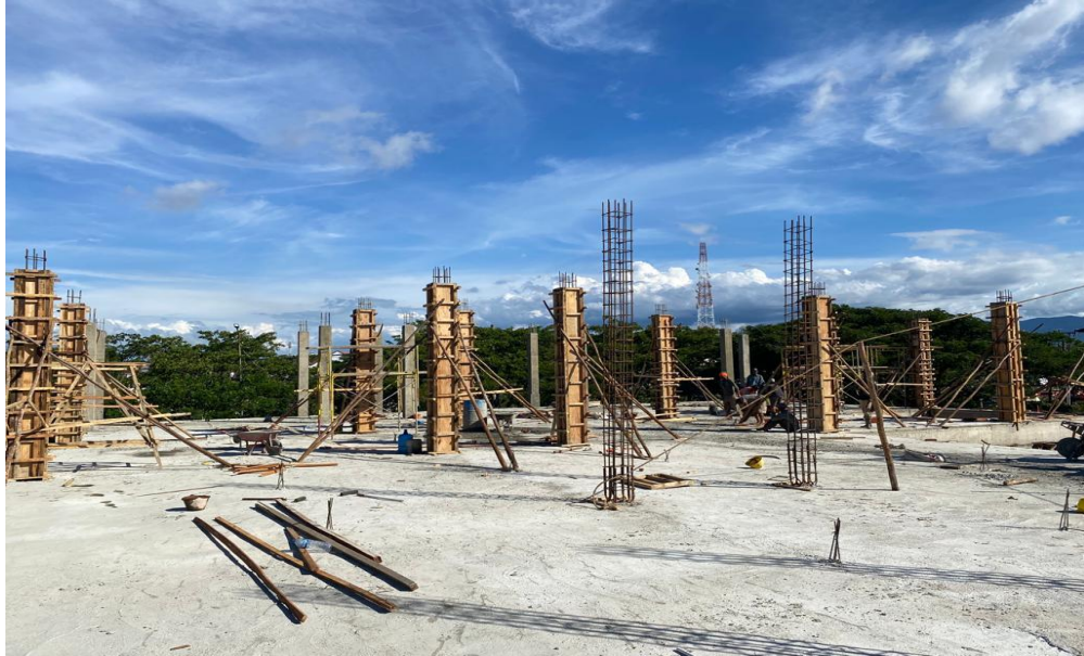
Lampiran A.2.3 : Pengecoran Kolom Lantai 1 waktu : 29 November 2023
