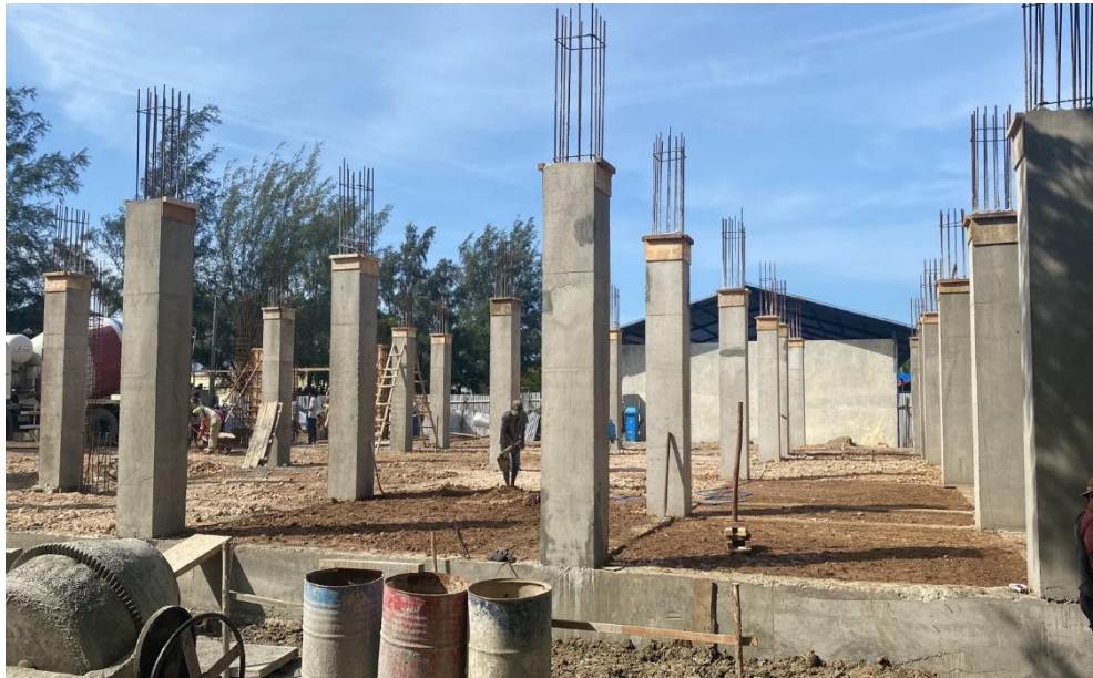
Lampiran A.2.1 : Pengecoran Kolom Lantai 1 waktu : 18 November 2023
