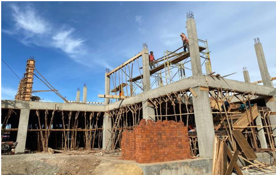
Lampiran A.2.4 : Pemasangan Bekisting Balok dan Lantai 2 waktu : 29 November 2023
