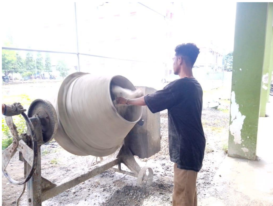
Gambar A.15 : Pengecoran
