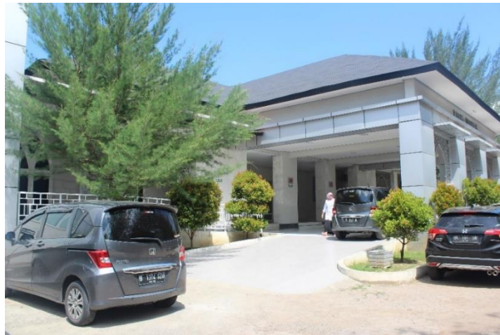
Gambar 2.4 Ramp Sumber: Dokumentasi Pribadi, 2018
