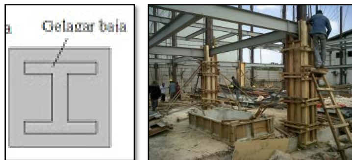
Gambar 5.19 Struktur Beton Tulangan Baja Sumber: Dewi Ayu, 2011
