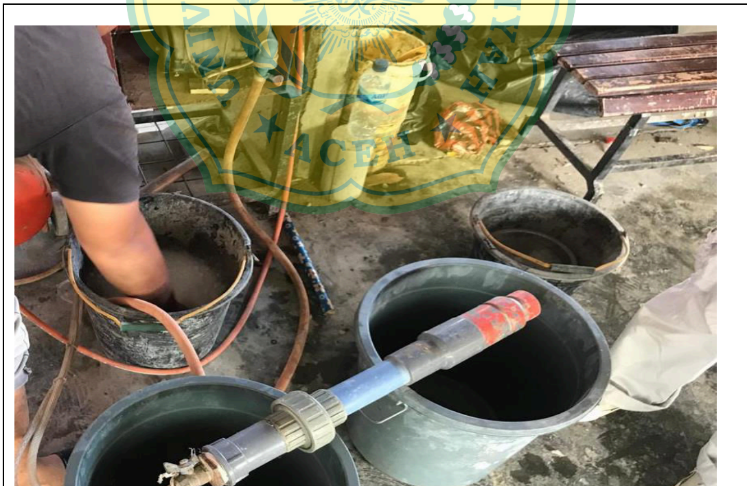
Gambar A.5.1 Proses persiapan foam agent untuk pengecoran Sumber : Dokumentasi lapangan
