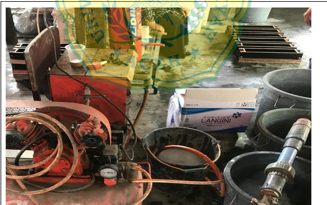
Gambar A.4.1 Persiapan mesin foam generator Sumber : Dokumentasi lapangan
