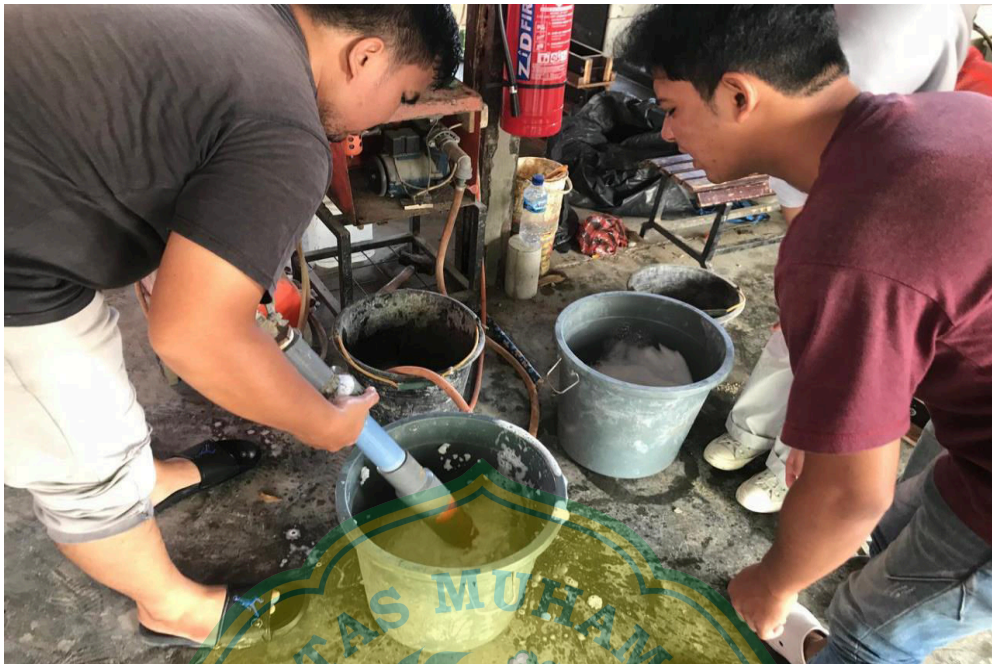
Gambar A.5.2 Pembuatan foam dengan foam generator dan kompresor Sumber : Dokumentasi lapangan
