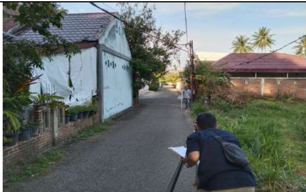
Gambar A.3.12 : Pengukuran Long Section Sumber : Lokasi Penelitian
