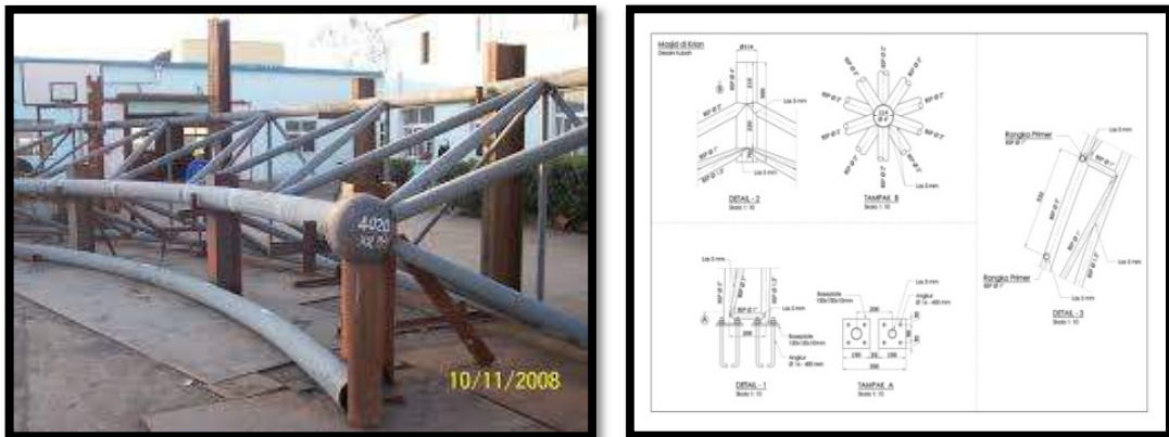
Gambar: 5.17 Struktur Atap pipa baja (Sumber : Analisa, 2020)
