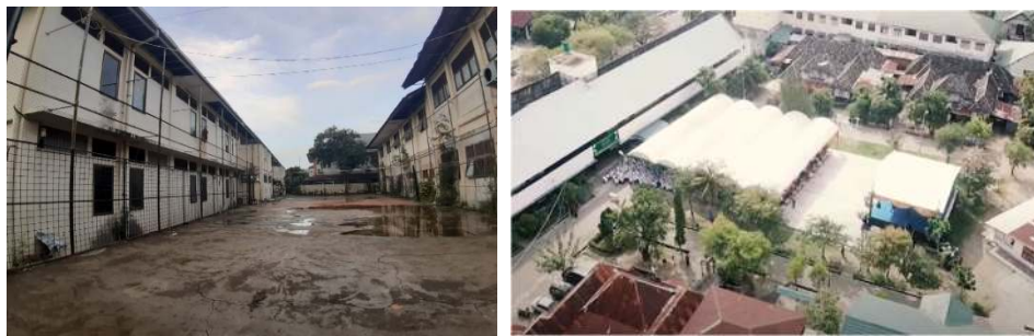
Gambar 2.6 Kondisi Lapangan Sumber : Dokumentasi Dayah Modern Darul Ulum
