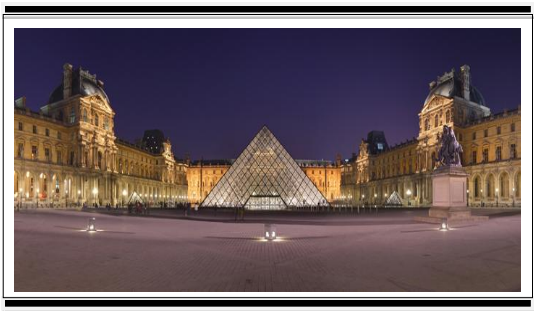
Gambar 3.16 Tampak depan Piramida Louvre Sumber. Galeriarsitektur, 2015
