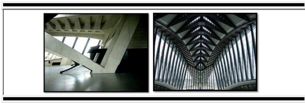
Gambar 3.11 Interior dari struktur Stasiun TGV Lyon Sumber. Hasnahaslinda, 2015
