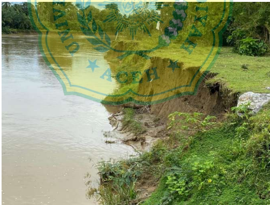
Gambar A.3.12 : Gambaran Erosi Sungai Sumber : Desa Marek, 2025
