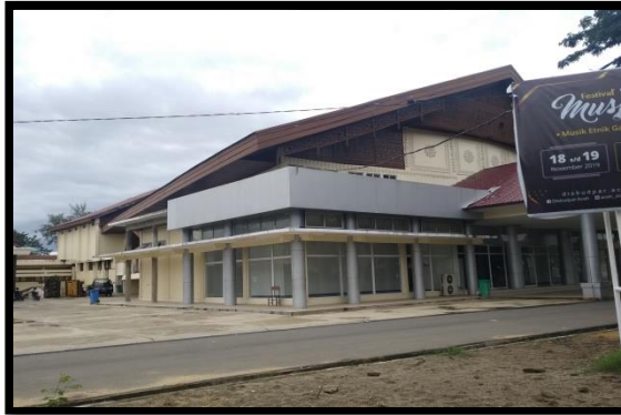
Gambar 2.2 Gedung utama (teater tertutup) Sumber : Survei, 2019
