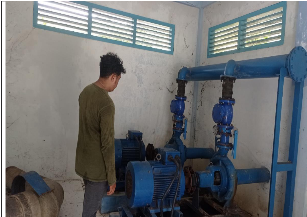
Gambar A.3.11 : Mesin pompa air PDAM di Lambadeuk Peukan Bada Sumber : Lapangan (2 Desember 2023)
