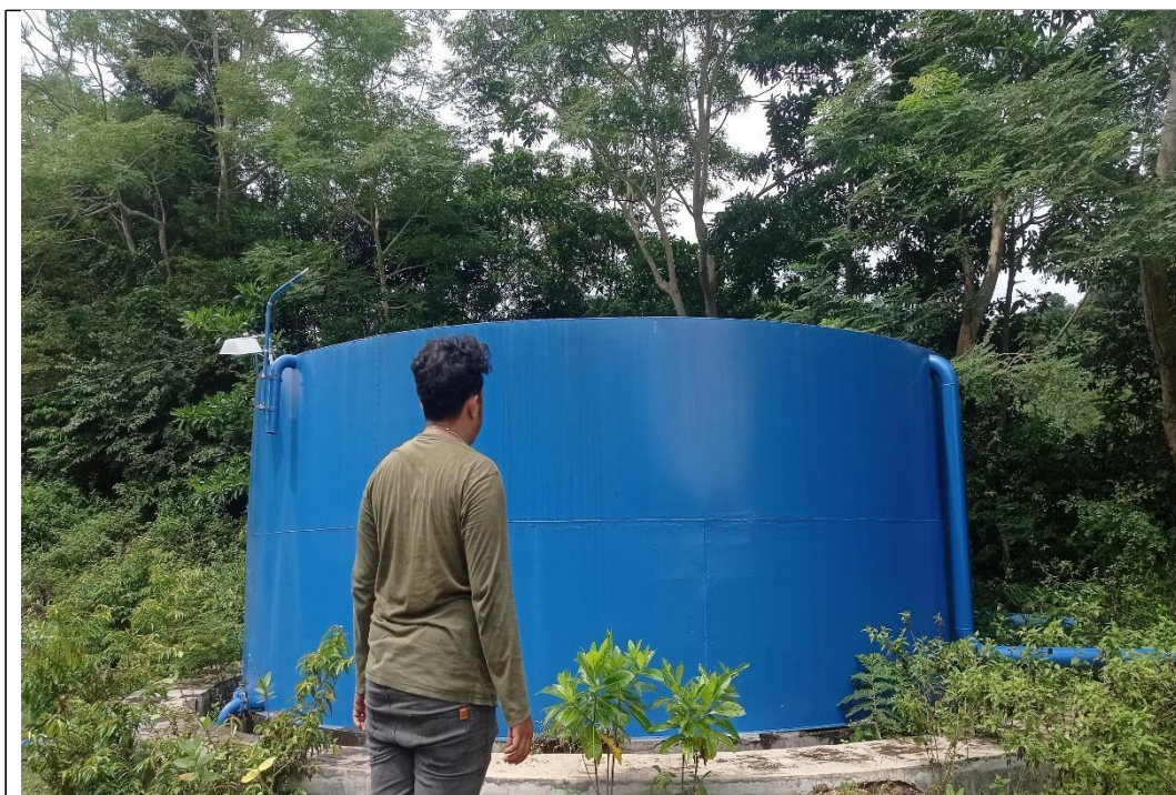
Gambar A.3.10 : Reservoar plat baja di Lambadeuk Peukan Bada Sumber : Lapangan (2 Desember 2023)
