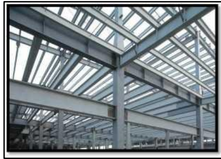
Gambar 5.10 Struktur baja (Sumber : http://struktursipil.blogspot.co.id , 2021)
