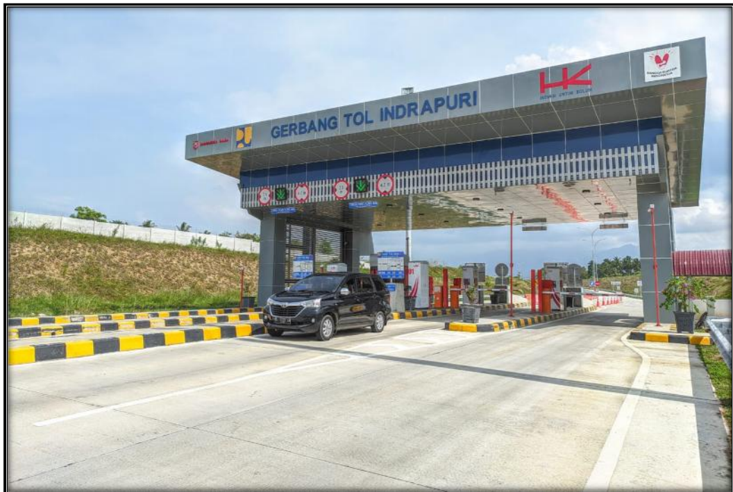
GAMBAR A.3.5 : GERBANG TOL INDRAPURI SUMBER : DOKUMENTASI
