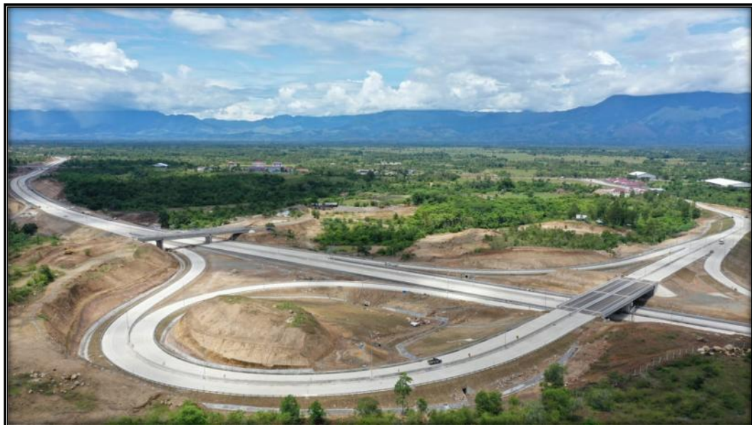
GAMBAR A.3.6 : TAMPAL ATAS ENTERCHANGE INDRAPURI SUMBER : PT. HUTAMA KARYA
