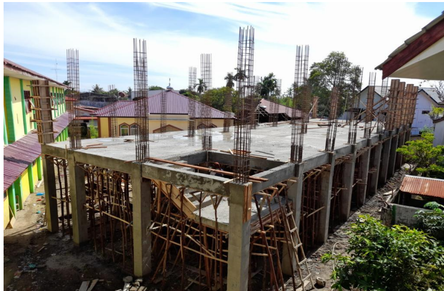
Gambar A.6 : Dokumentasi Pekerjaan Sumber : Penulis (2023)
