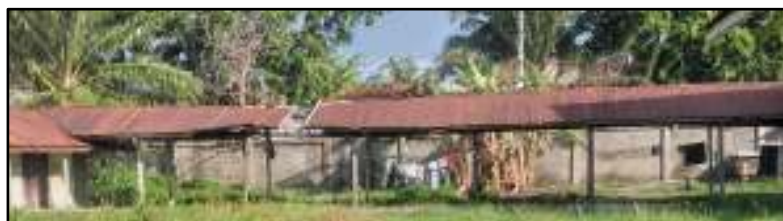
Gambar 5.3 : Bangunan parkir lama pada tapak Sumber : pribadi, 2022
