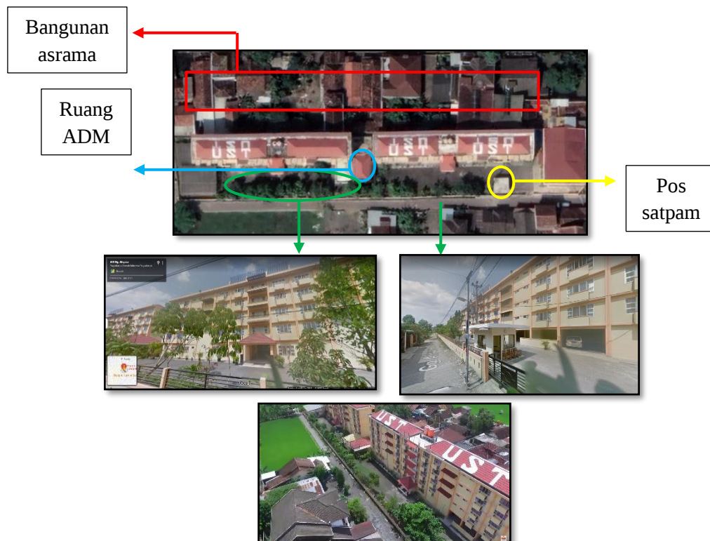
Gambar 2.26: Eksterior pada bangunan Asrama Sumber ; fp.ustjogja.ac.id
