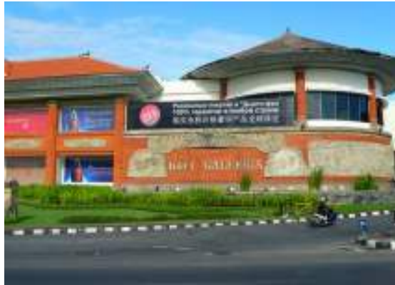
Gambar 3.1 Bali Galeria Mall,Bali Sumber: malbaligaleria.co.id
